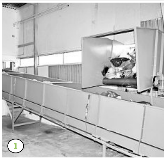
ANLIEFERUNG: Die Säcke aus den Sammelcontainern fallen am Anlieferpunkt auf ein Transportband und fahren in die Sortierhalle.
